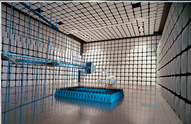
Blick in die beiden 10m-Absorberhallen des EMC Center Erlangen und eine Vor-Ort-Messung bei der deutschen Bahn.
